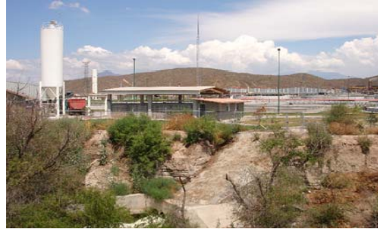
Figura 3.2. Silo de cal a la izquierda de las instalaciones para manejo de lodos en la PTARM-Principal
