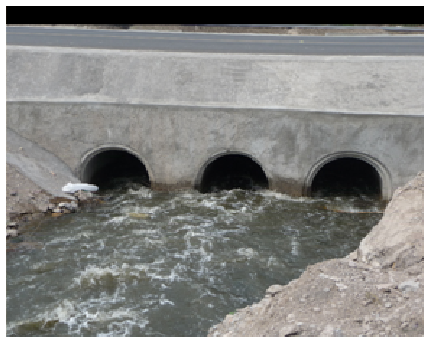
Figura 3.14. Arroyo La Encantada (cruce con carretera paralela a Los Pinos, al sur de Ramos Arizpe)
