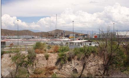
Figura 3.1. PTAR-Principal, al fondo la planta de DeAcero, cliente potencial para el agua residual tratada
